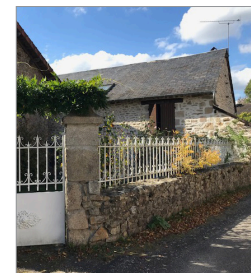
Toiture en ardoise Bourg - Source : 6t 2018
