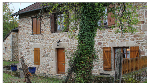
Encadrement des ouvertures en pierre Lignac - Source : 6t 2018
