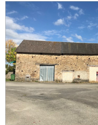
Grange agricole vacante Bourg - Source : 6t 2018
