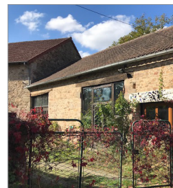
Toiture en tuile canal Bourg - Source : 6t 2018
